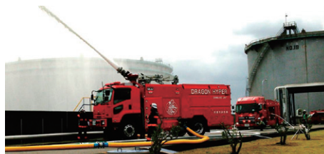
大型放水砲車による放水
